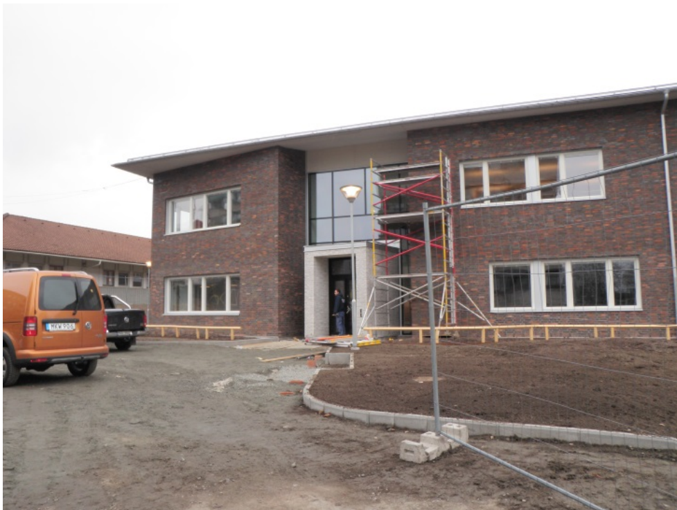
Bild 12: Bergsgårdsskolan mars 2015. Slutbesiktning.
