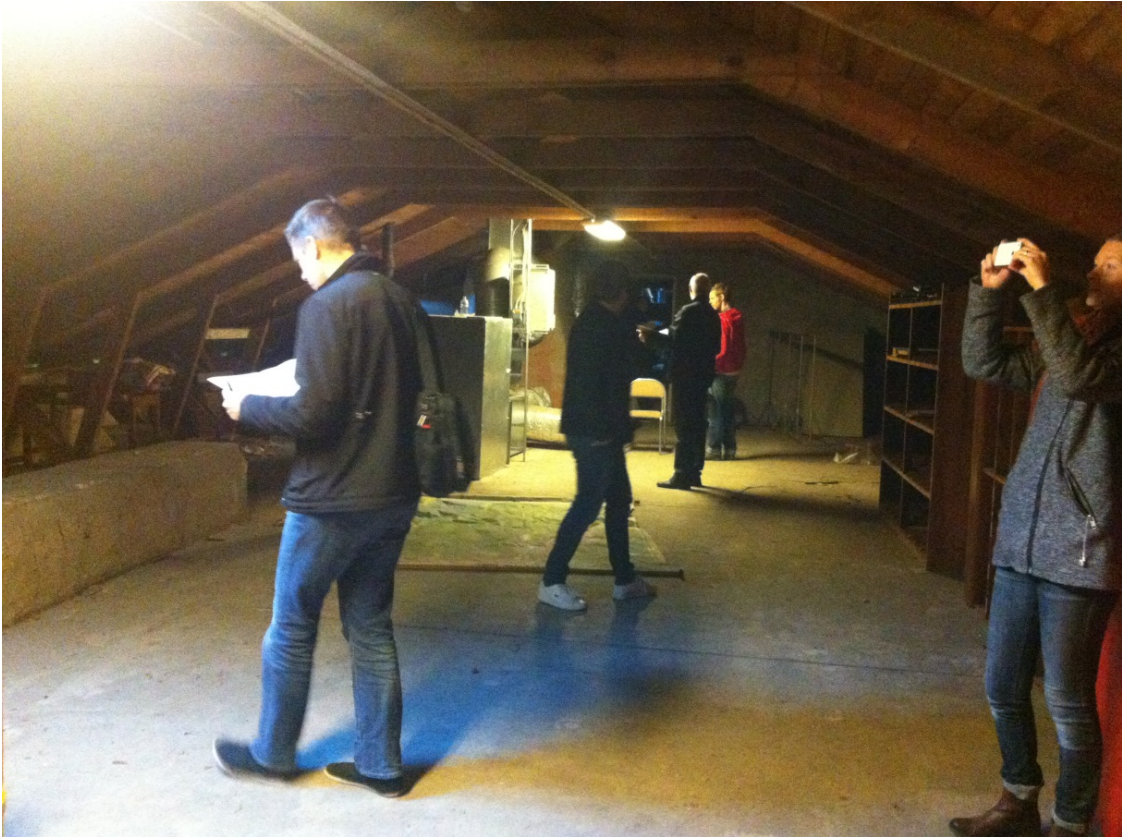
Bild 4: Johannebergsskolan okt 2014. Konsultgruppen inspekterar befintligt ventilationssystem.
