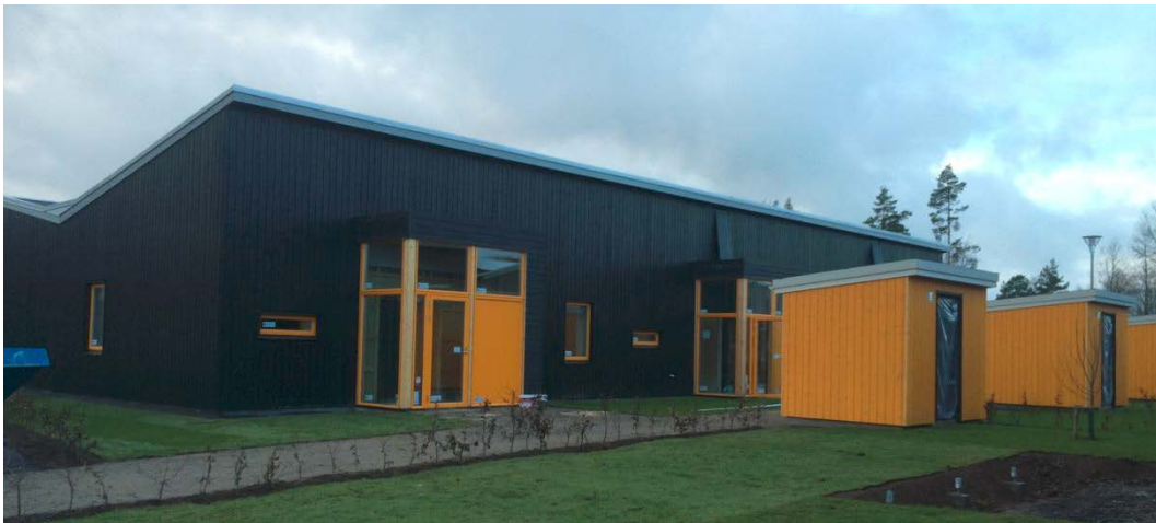
Bild 17: Solallén Växjö (Bildkälla Skanska)
