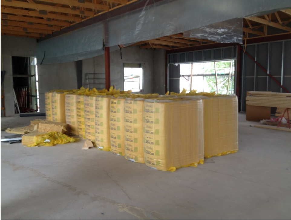
Bild 10: Bergsgårdsskolan aug 2014. Notera plastfolien som lagts på stålbalcken före det att takstolarna lyfts på plats. Denna enkla åtgärd skapar bra förutsättningar för god lufttätethet vid denna detalj. Notera också värmeisoleringen som förvaras skyddad från nederbörd inomhus.
